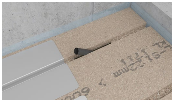
Figur 7 Kontrollér at tomrørets ende er i niveau med gulvpladen.
