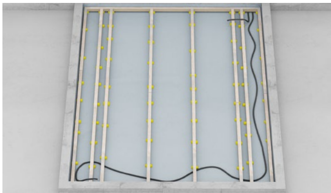
Figur 2 Tomrøret udlægges under gulvstrøerne og fastgøres inden montering af Klimagulvpladerne.
